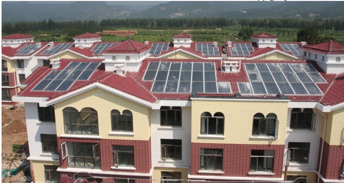
图6 北京市延庆旧县新型农村社区太阳能与建筑一体化采暖与生活热水示范项目
