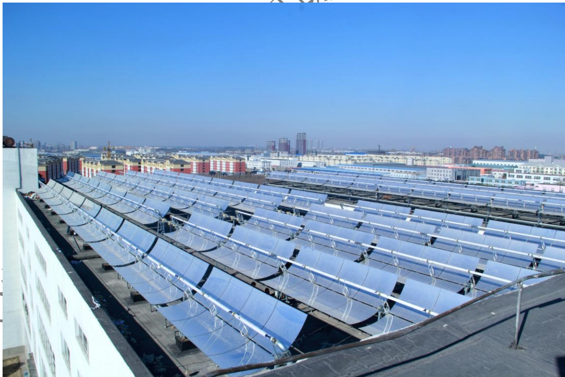
图 7 中国医科大学沈北校区游泳馆热水、除湿项目
